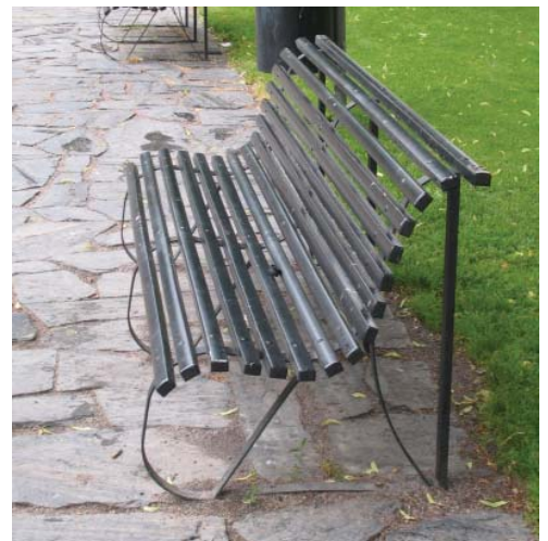
Kuva 8. Lahti -penkin (Lehtovuori Oy) istuinmateriaalina oleva maalattu koivu on kestänyt hyvin sääolojamme.
