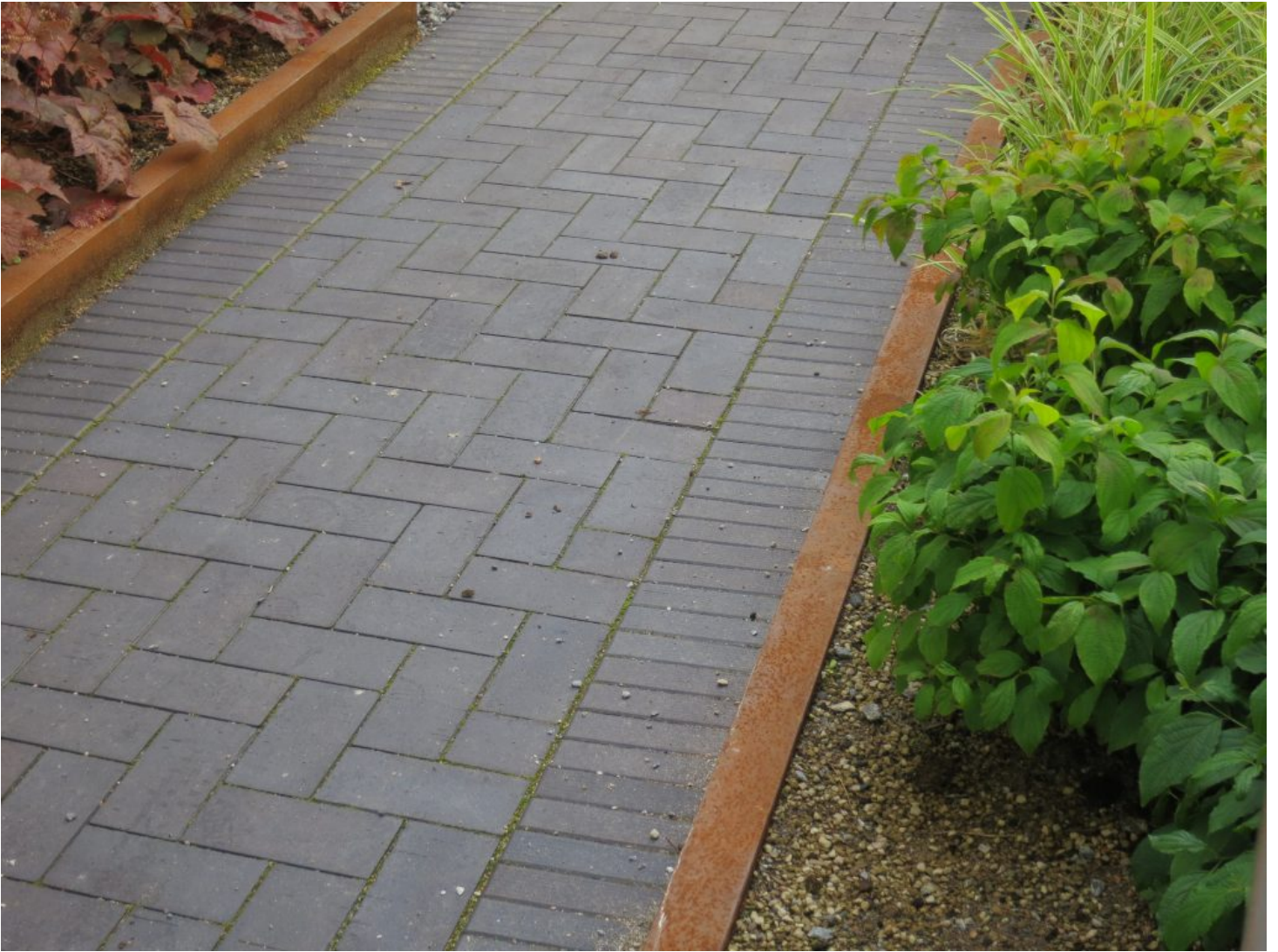
Leveä Corten-teräksestä tehty reunatuki.
