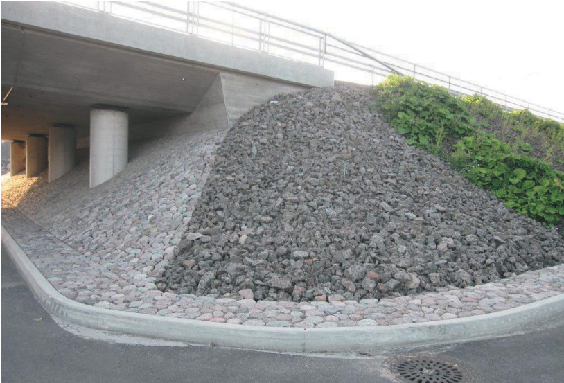
Kuva 1/9. Molskottiverhous keilassa.
