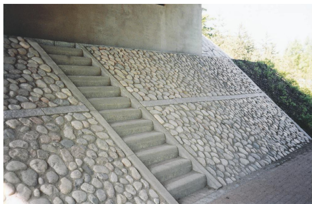
Kuva 27. Tarkastustasanne etuluiskan yläosassa ja tasanteelle johtavat portaat.
