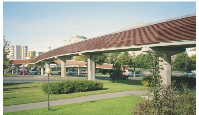
Kuva 6. Kaupunkiympäristön siltapaikka (Keon ylikulkukäytävä, Raisio).
