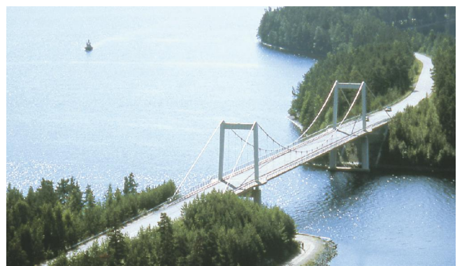
Kuva 8. Siltapaikka harjumaaisemassa (Karisalmen silta, Asikkala).
