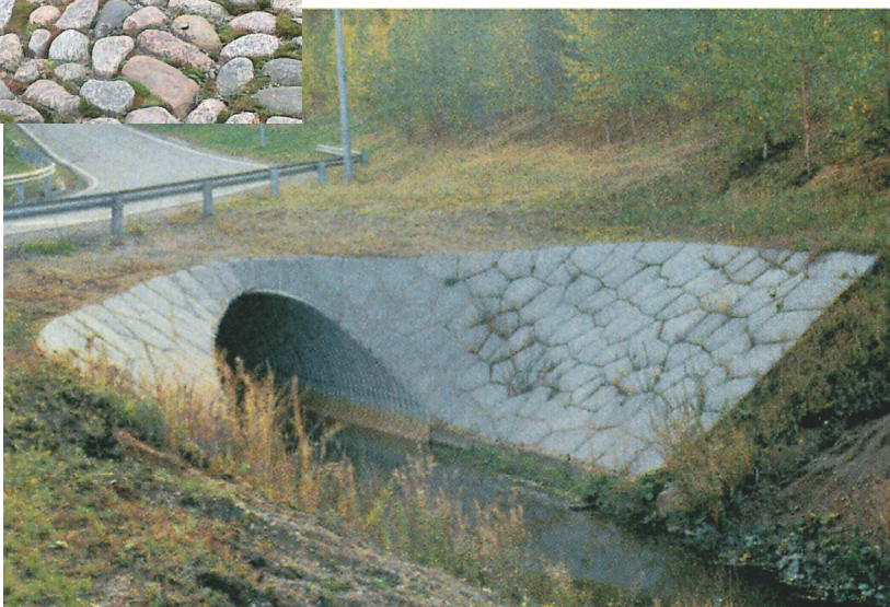
Kuva 1/4. Tiivissaumainen verkkoverhous.
