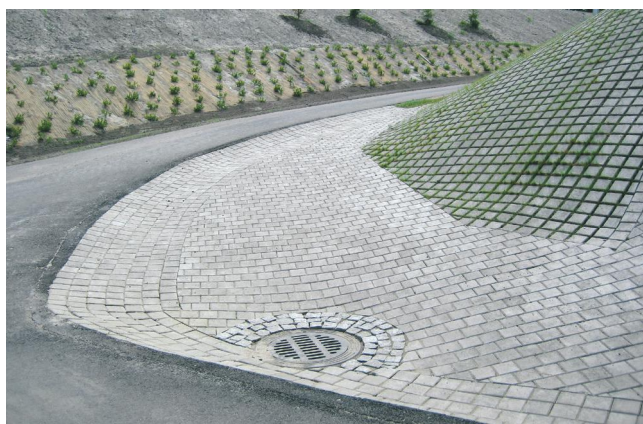
Kuva 19. Betonikiviverhoamista.
