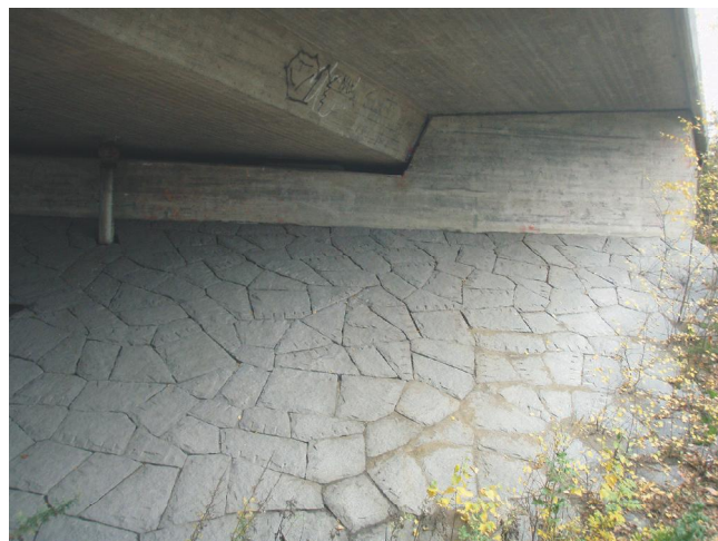
Kuva 37. Huolellisesti tehty etuluiskan kivilaattaverhouk.
