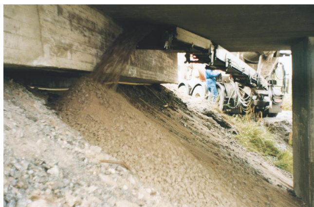
Kuva 31. Verhousteri- aalin siirtoa kansilaatan alle hihnakuuljettimella.
