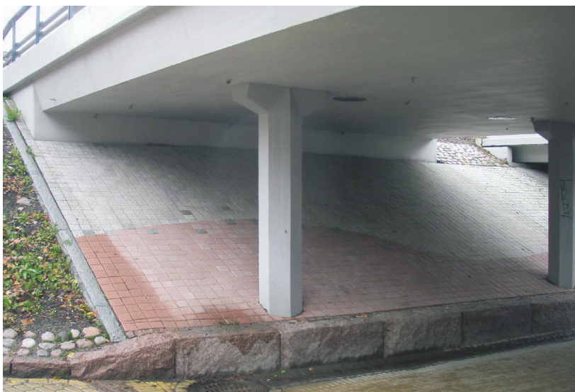
Kuva 2/1. Betonikiviverhous etuluiskassa.
