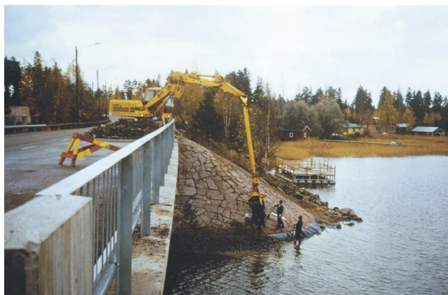
Kuva 16. Keilan kivilaattaverhousta korjataan.
