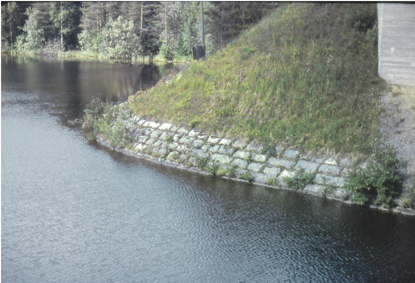
Kuva 1/5. Palkkiverhous keilan alaosassa.
