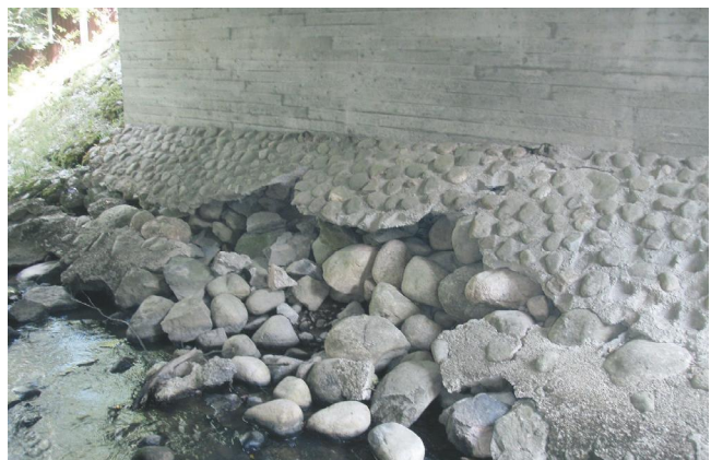
Kuva 11. Eroosiovaurio etuluiskassa.
