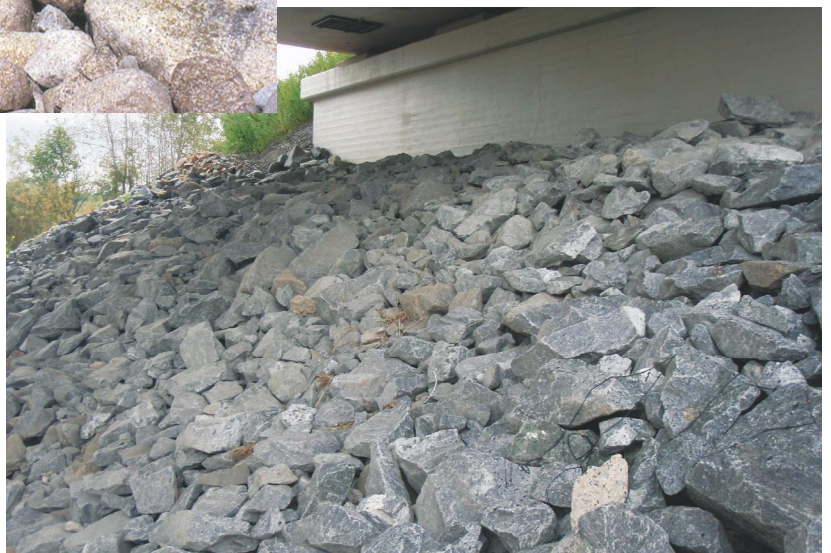
Kuva 1/8. Järjestetty kiviheitokeverhous.
