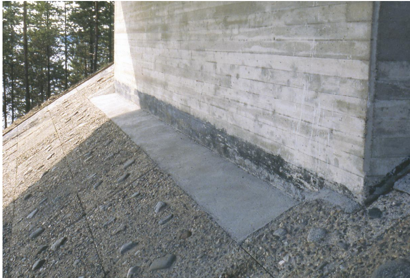
Kuva 2/5. Betonilaattaverhous ja tarkastustasanne.
