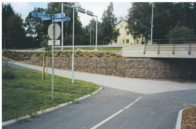
Kuva 20. Säännöllisen muotoinen tukimuuri kivikoreista.
