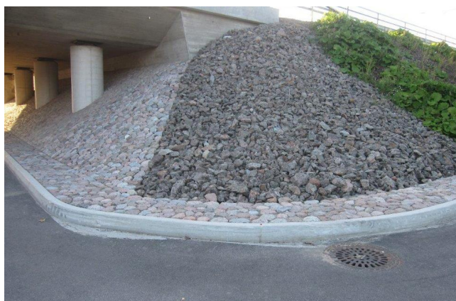
Kuva 17. Etuluiskassa kenttäkiviverhous ja keilassa molskottiverhous.
