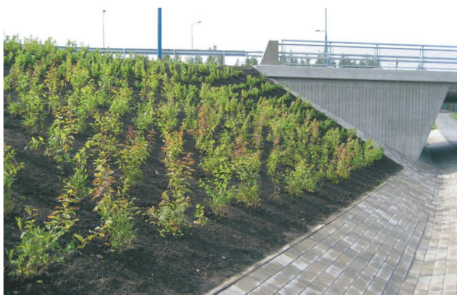
Kuva 3. Siltapaikkaa pehmentävä pensasverhous.
