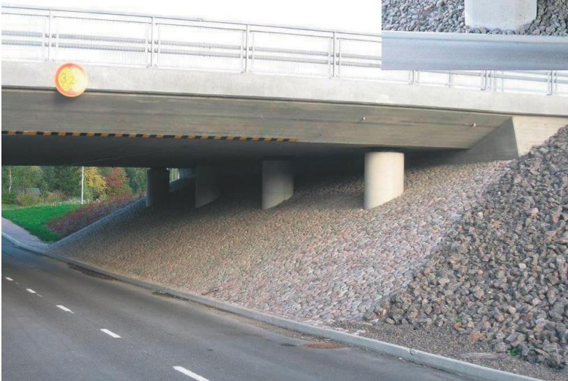
Kuva 1/11. Kenttäkiviverhous etuluiskassa.
