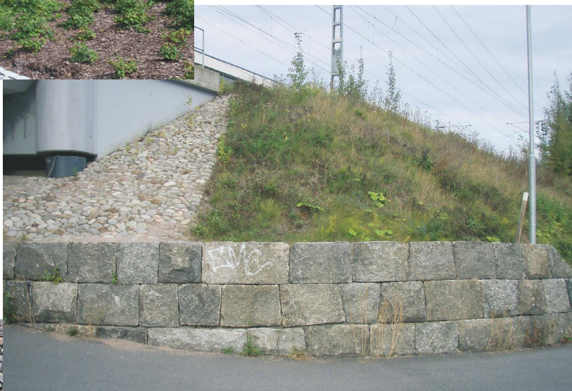
Kuva 1/2. Vanhoista kivistä tehty kylmämuuri.
