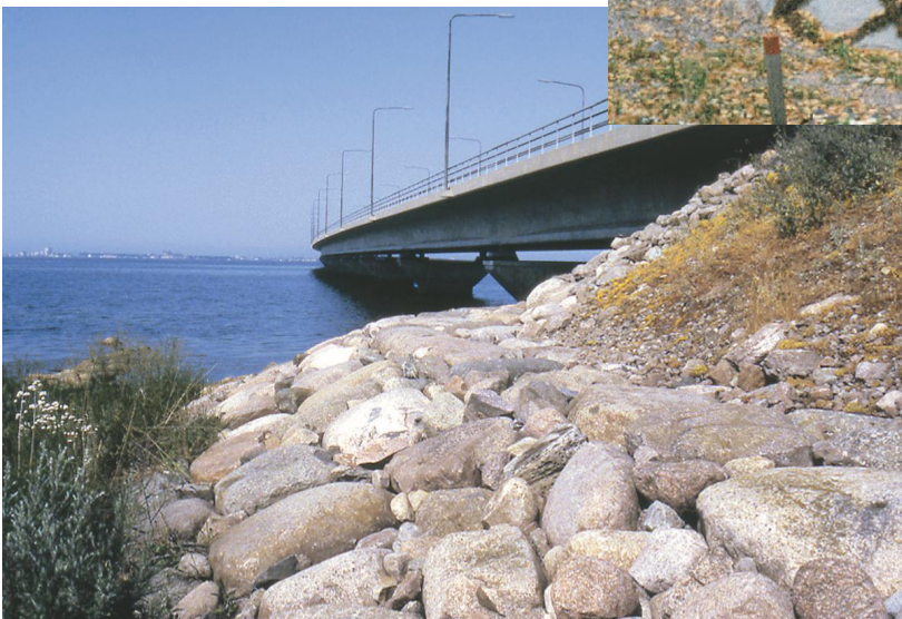
Kuva 1/7. Massiivinen kiviheitokeverhous.
