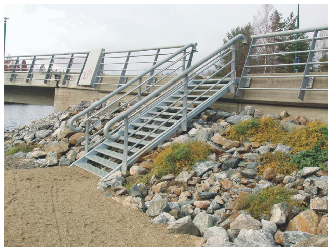
Kuva 40. Teräsporras sillan päässä.
