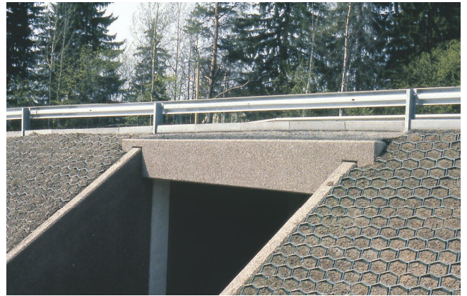
Kuva 14. Nurmiverhous on sidottu muovikennolla.
