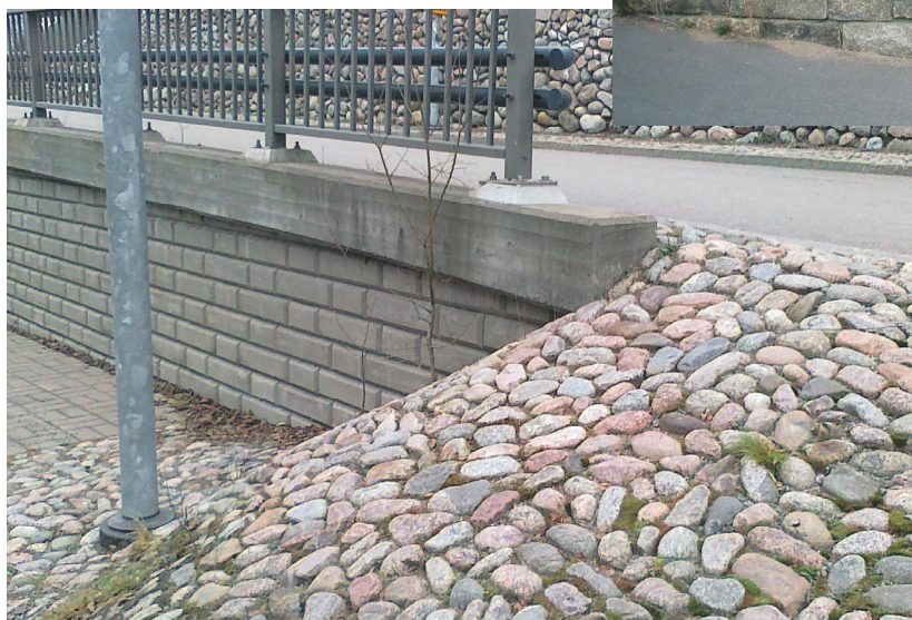
Kuva 1/3. Kenttäkivipintainen keilan ja tukimuurin verhous.
