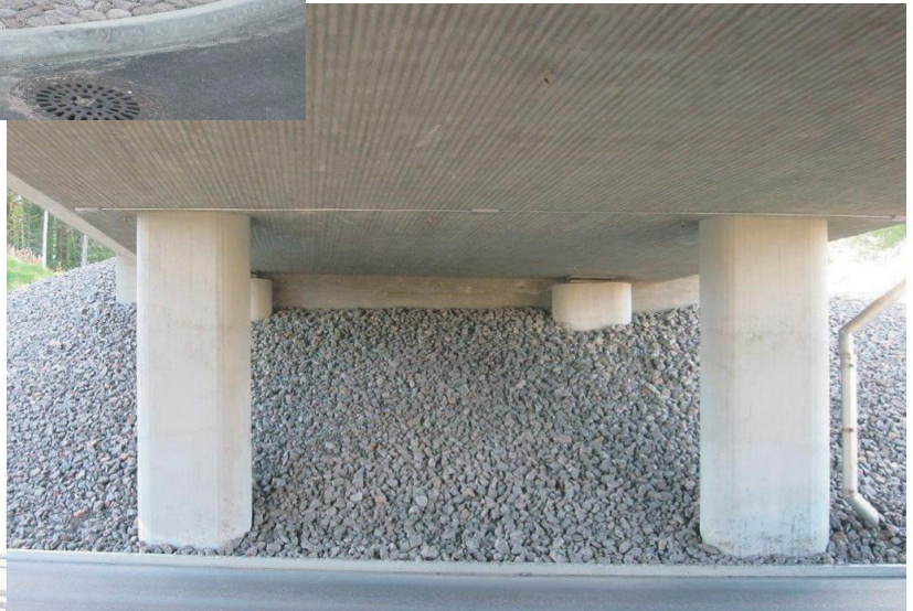
Kuva 1/10. Sepeliverhous etuluiskassa.
