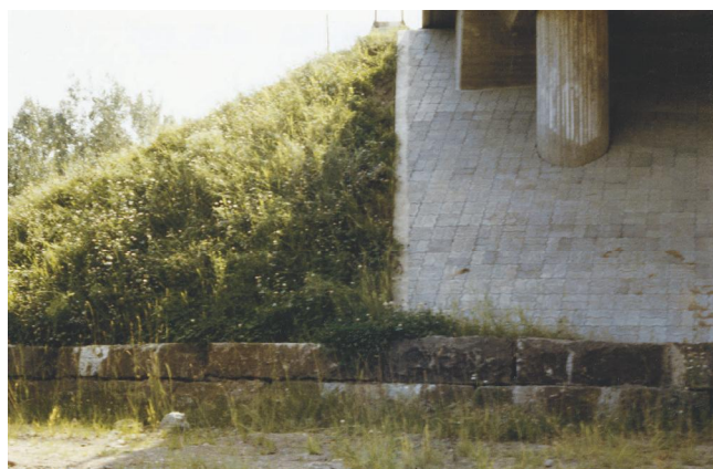
Kuva 32. Kylmämuuri keilan ja etuluiskan juuressa.
