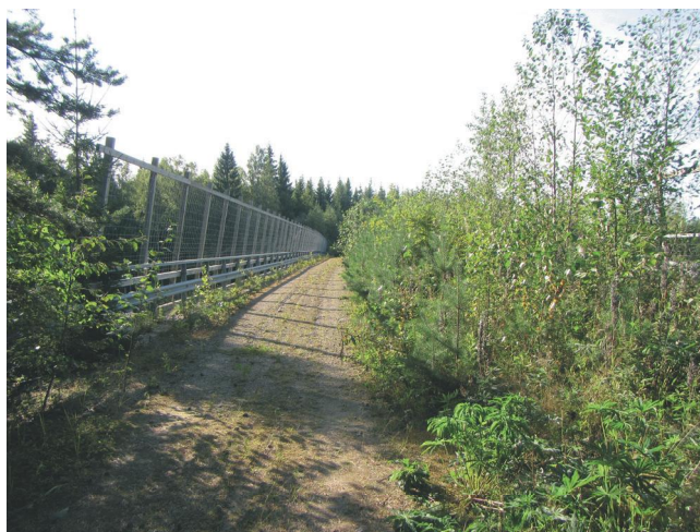
Kuva 13. Viherrakenteet sillan kannella.
