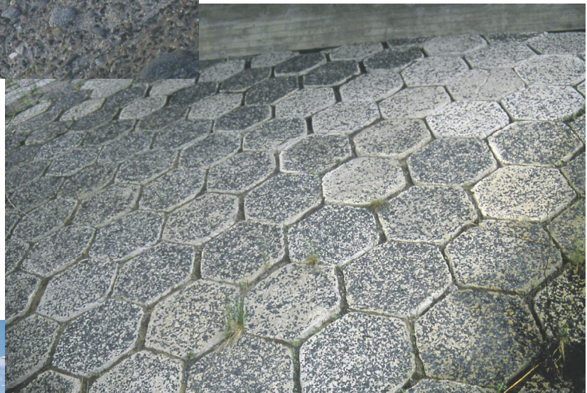
Kuva 2/6. Pesubetonilaattaverhous.
