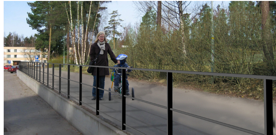
Kuva 4. Havainnekuva harvan kaiteen käytöstä alle 700 mm pudotuksen kohteessa.
