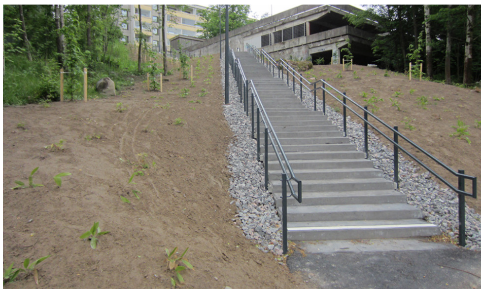
Betoniportaat (kuva Helsingin kaupunki, J-P Koljonen)
