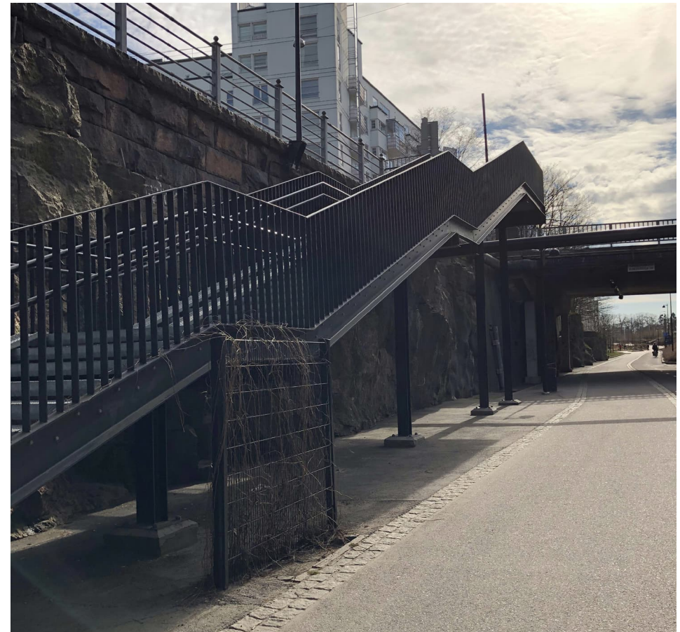
Baanan teräsriläportaavat ovat kustannustehokkaita ja vanhaan rataympäristöön sopivat.
