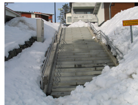
Lämmitetyt portaat keskellä talvikunnossapitämätöntä aluetta.
